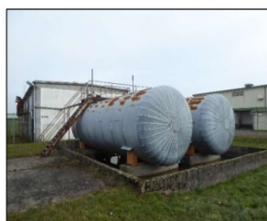
Abbildung 2.7-8: Öltank mit Auffangbecken, Geb. #4155
